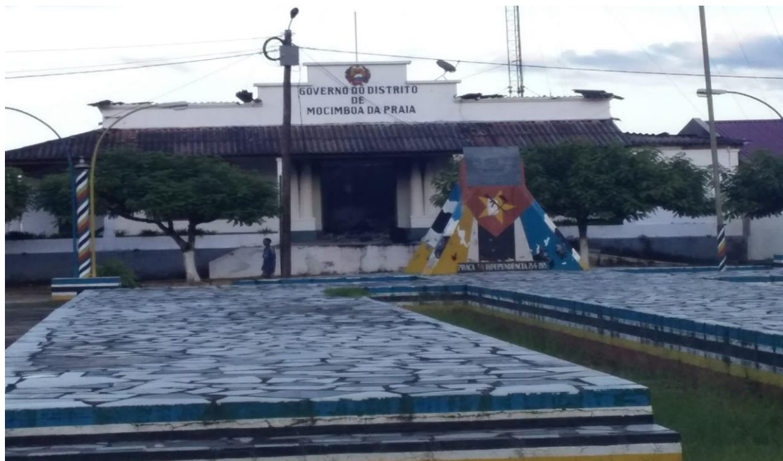
Imagem 7 - Edifício do Governo do Distrito de Mocimboa da Praia destruído
