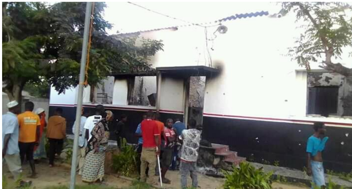
Imagem 9 - Edifício do Comando Distrital da PRM de Mocimboa da Praia destruído
