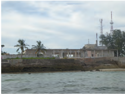
138_Old Complexo Desportivo.JPG
