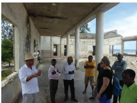
144_Old Complexo Desportivo.JPG
