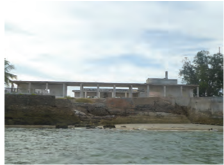
139_Old Complexo Desportivo.JPG
