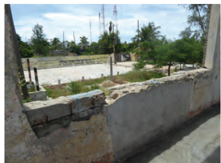
145_Old Complexo Desportivo.JPG
