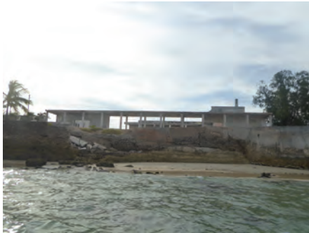
140_Old Complexo Desportivo.JPG
