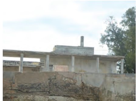
141_Old Complexo Desportivo.JPG
