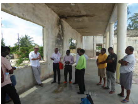
146_Old Complexo Desportivo.JPG
