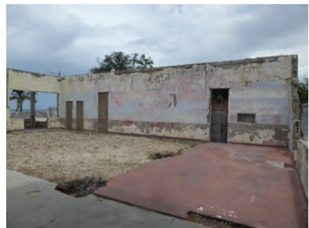
143_Old Complexo Desportivo.JPG
